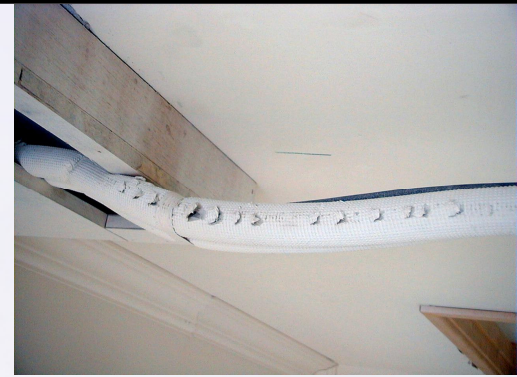
錯誤的保溫材 (無保溫效果、容易破損、易結露)
